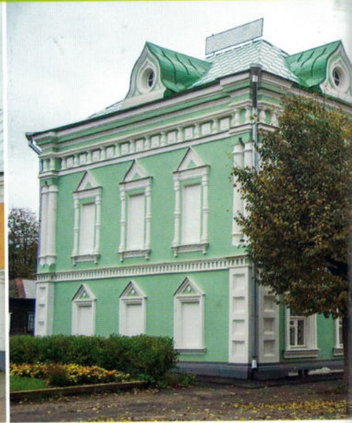
▲ Краеведческий музей помещился в здании, выстроенном в свое время для Городской думы, — с включением в постройку старинных соляных амбаров.
